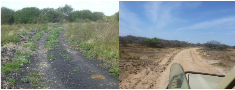
Verbesserung der Fahrpisten mittels Planiergeräten
