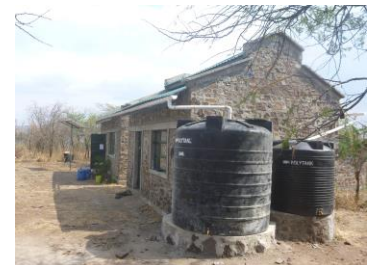
Neue Wassertanks bei einem Rangerposten
