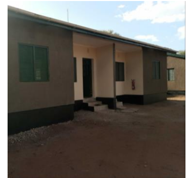
Renovation von Rangerposten
