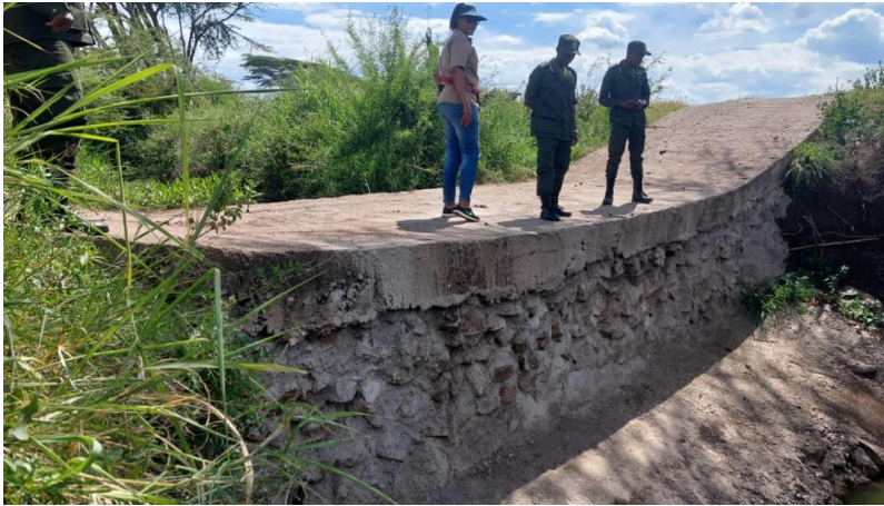
Reparatur und Ausräumarbeiten bei der Idilungwa Furt im Serengeti Nationalpark
