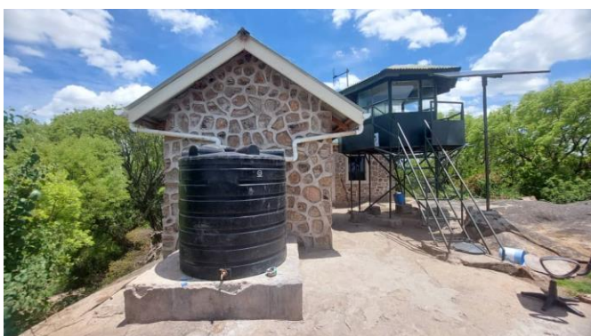
Mbungu Observation Post: Renovation des Wassertanksystems im Serengeti Nationalpark
